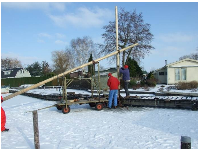
De botenwagen in gebruik als kraan voor de palen.
